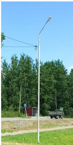
Стойки выполнены из металла. Высота стоек 9 м. (3 м. под землей, 6 м. над землей) диаметр 108 мм.- 4 м., диаметр 86 мм – 5 м., диаметр 40 мм. - 1,5 м.
