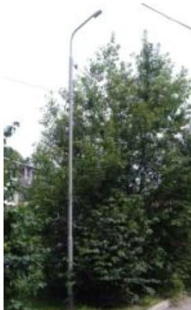
Стойки выполнены из металла. Высота стоек 9 м. (3 м. под землей, 6 м. над землей) диаметр 108 мм.- 4 м., диаметр 86 мм – 5 м., диаметр 40 мм. - 1,5 м.
