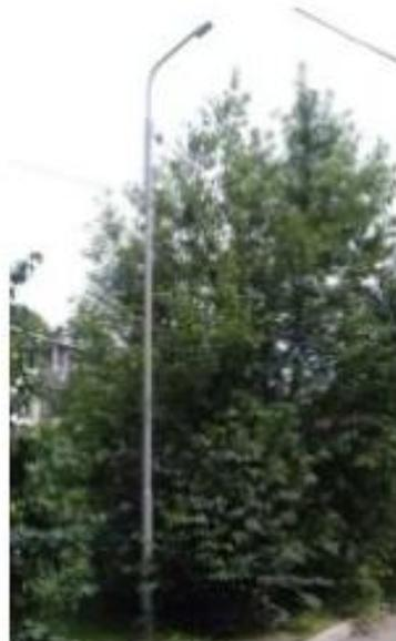
Стойки выполнены из металла. Высота стоек 9 м. (3 м. под землей, 6 м. над землей)
